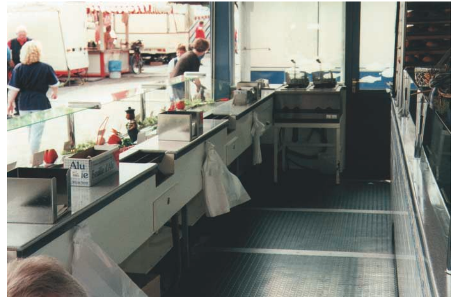
Abb. 1: Beispiel für einen hygienisch geeigneten und rutschhemmenden Boden
